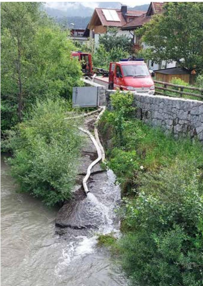
**Bis zu 5.000 Lit. Wasser/Minute können mit beiden Hochwasserpumpen vom Sammelschacht in die Rienz gepumpt werden.**
